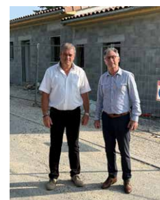
Le Maire et le sous-préfet, visite du chantier des 3 logements seniors
